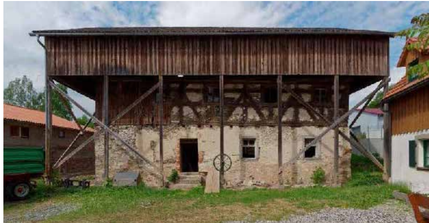
Die Mühle mit dem Notdach, um die Substanz zu sichern, bis die Sicherung selbst in die Not kam.
